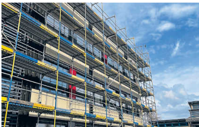
Fassadenarbeiten am neuen HGÖ-Gebäude
