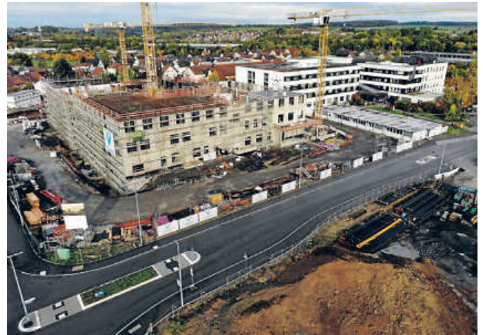
Baustelle des Hohenloher Krankenhauses an der Kastellstraße Foto: Stadt Öhringen
