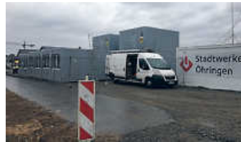
Container für das Bauteam Foto: Stadt Öhringen
