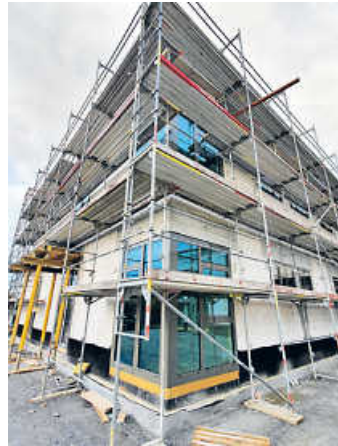
Detail der neuen Fenster
